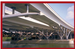
Humboldthafenbrücke am Hauptbahnhof Berlin
