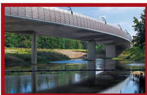
Lautrupsbachtalbrücke in Flensburg
